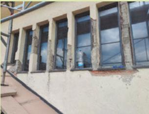
Die Kittfugen bei den Fenstern waren altersbedingt undicht, asbestbelastet und mussten ersetzt werden. Auch defekte Glasscheiben mussten ersetzt werden.
