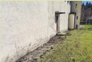
Auf der verputzten Aussenhülle waren unter den jahrelangen Wiedereinflüssen sehr starke Abnutzungen sichtbar. Risse und eindringendes Wasser erforderten grössere Instandstellungsarbeiten an der Fassade und an den Umgebungsmauern.
